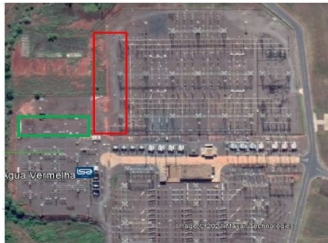
Figura 3: retângulo vermelho indica o local de instalação do TR e módulo de conexão 500 kV e retângulo em verde indica o local do módulo de conexão 138 kV
